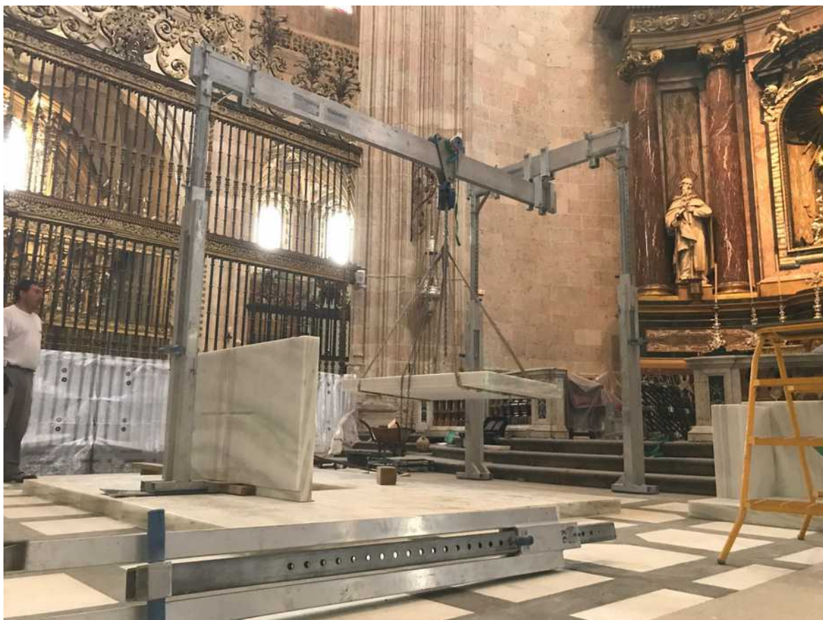
REPORTAJE CORTESIA DE AURELIO GONZALEZ HERMANOS, S.A. DEL USO DE UNA GRUA PORTICO DE 1,5 TN CON EXTENSIONES LATERALES EN EL INTERIOR DE UNA CATEDRAL
