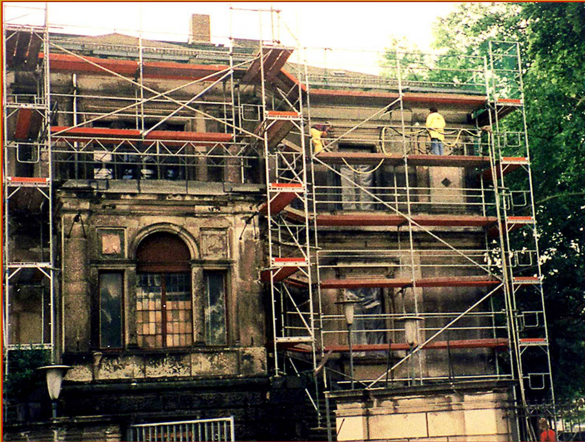
REHABILITACION DE FACHADAS HISTORICO ARTISTICAS CON CHORROS DE PRECISION "POWER SOFT" DE GOLDMANN - PARA SECO Y EN HUMEDO
