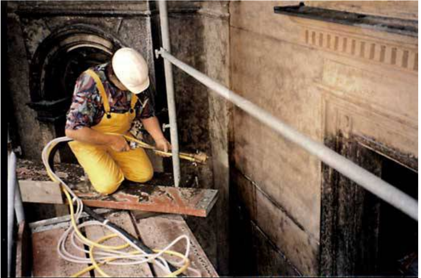
LIMPIEZA DE FACHADAS Y MONUMENTOS CON CHORRO DE ABRASIVO EN HUMEDO
